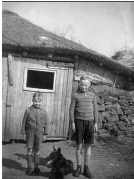
Op de achtergrond de met russen (graszoden) opgetrokken noodschaapskooi van Woute Piet in 1946. De kooi is volledig door buurtgenoten, familieleden en vrienden gebouwd. Vooral Jan van d'n Hollander (Lavrijsen) heeft er dag en nacht aan gewerkt.
