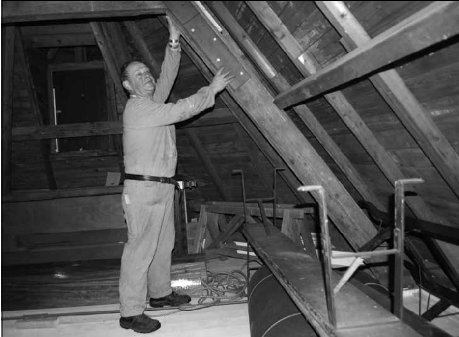
Toon Schellens bij het door hem gerestaureerd spant van de doopkapel van de Reuselse kerk. De houten constructie heeft veel averij opgelopen tijdens de oorlogsverwoestingen in september 1944.
