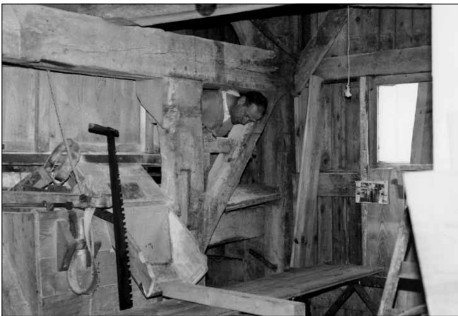
Toon Schellekens in mei 1988 bezig met de restauratie van de houten constructie van de Colse Watermolen van Tongeren (Eindhoven). Bij dit soort werk was Toon in zijn element.
